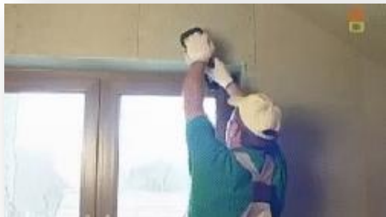
Шлифовка стыков при необходимости
