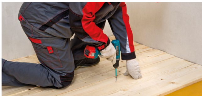
Рис. 5.4.а. Монтаж чернового пола
