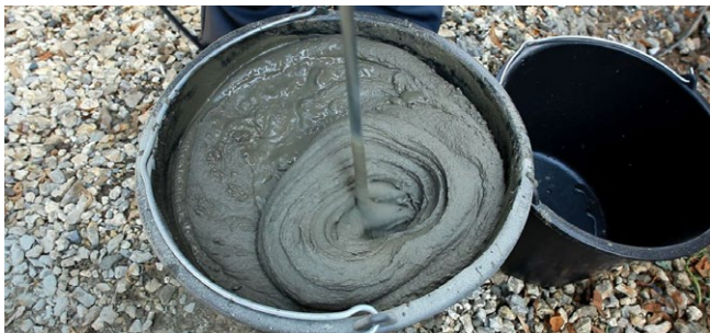
Рис. 7.27. Замешивание клея для приклейки теплоизоляции
