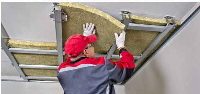
Рис. 5.21. Укладка плит ТЕХНОАКУСТИК
