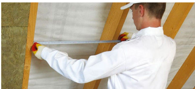
Рис. 4.2. Подготовленная система для дальнейшего монтажа теплоизоляции
