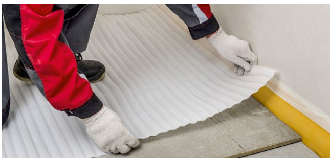
Рис. 5.14. Укладка подложки под финишное покрытие пола
