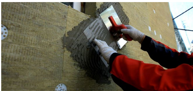
Рис. 7.38. Установка усиливающих элементов из армирующей сетки вокруг оконных проемов
