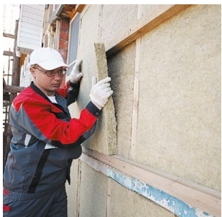
Рис. 7.4. Монтаж теплоизоляционных плит в горизонтальный каркас
