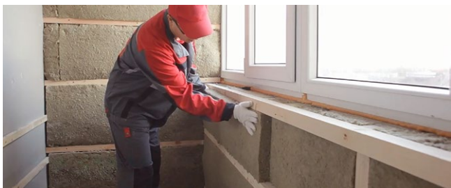
Рис. 7.45. Укладка плит теплоизоляции второго слоя
