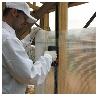
Рис. 7.20. Монтаж пароизоляционной пленки
