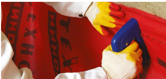
Рис. 4.5. Укладка и фиксация пароизоляционной пленки
