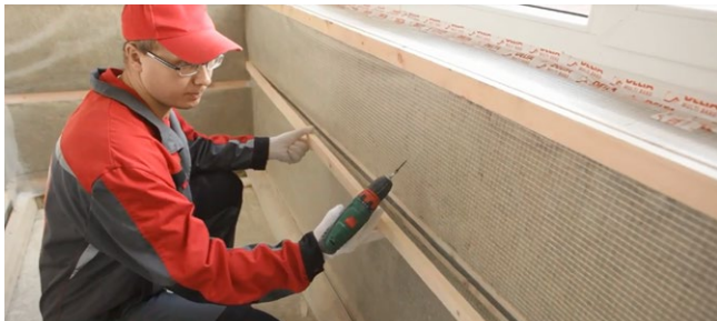
Рис. 7.47. Монтаж контррейки
