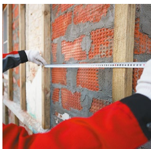
Рис. 7.1. Крепление вертикальных стоек деревянного каркаса
