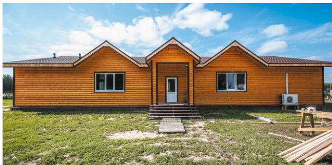
Рис. 7.23.б. Монтаж облицовочного материала
