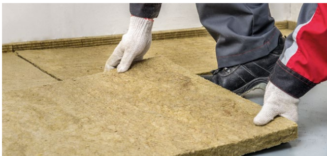
Рис. 5.8. Укладка плит ТЕХНОФЛОР СТАНДАРТ
