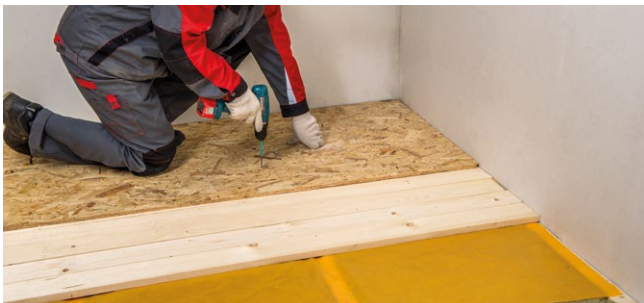
Рис. 5.4.6. Монтаж чернового пола
