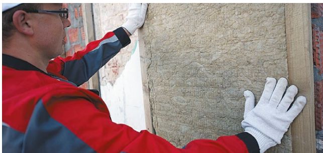
Рис. 7.2. Монтаж теплоизоляционных плит в вертикальный каркас
