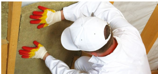
Рис. 4.3.6. Монтаж теплоизоляции враспор между стропилами
