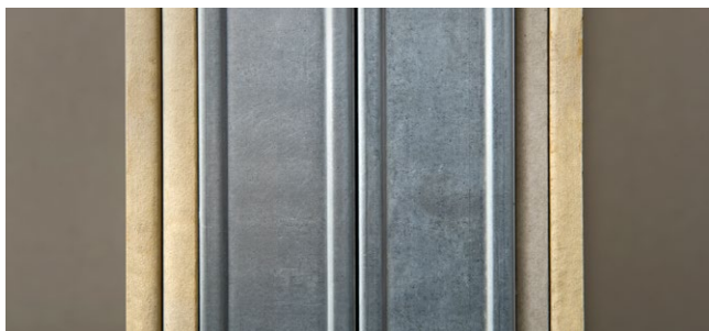
Рис. 6.7. Обшивка второй стороны перегородки листами ГКЛ
