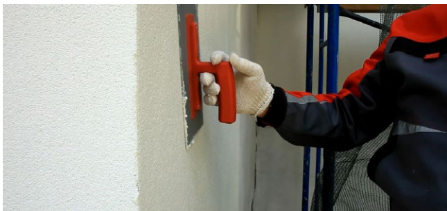
Рис. 7.41. Нанесение декоративного слоя штукатурки
