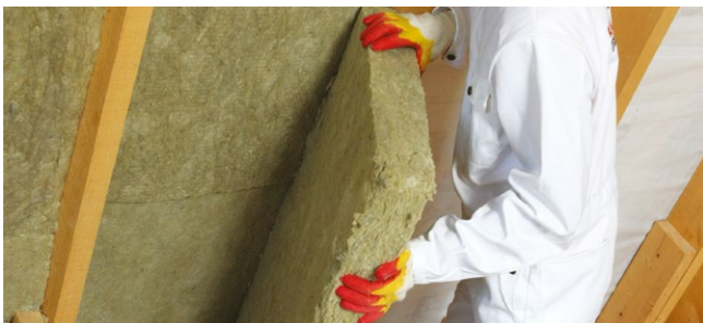
Рис. 4.3.а. Монтаж теплоизоляции враспор между стропилами
