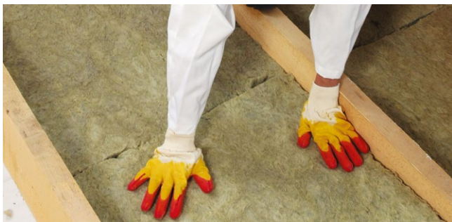
Рис. 4.11. Монтаж теплоизоляции между балками
