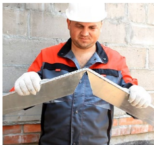
Рис. 7.26.а. Установка опорного профиля для первого ряда теплоизоляции с применением алюминиевого стартового профиля
