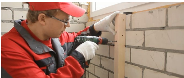
Рис. 7.42. Установка вертикального каркаса под теплоизоляцию
