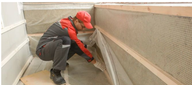
Рис. 7.51. Монтаж пароизоляционной пленки
