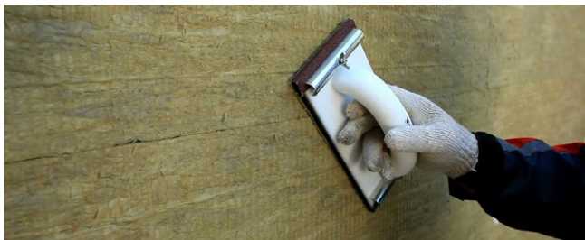
Рис. 7.34. Шлифовка стыков плит теплоизоляции наждачной бумагой
