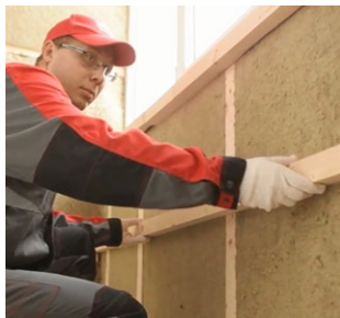
Рис. 7.44. Установка горизонтального каркаса под теплоизоляцию
