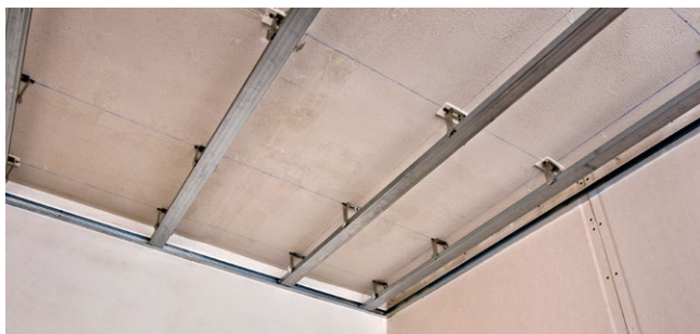
Рис. 5.20. Установка подвесов и потолочного профиля
