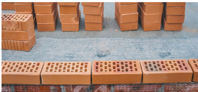
Рис. 7.8. Гидроизоляционная отсечка
