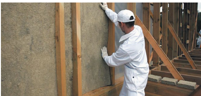
Рис. 7.21. Монтаж теплоизоляционных плит
