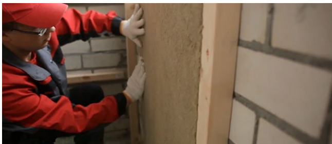
Рис. 7.43. Укладка плит теплоизоляции первого слоя
