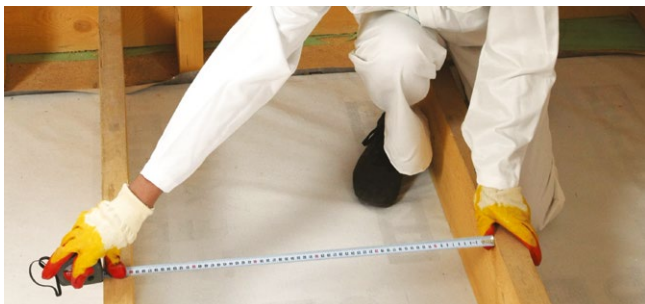
Рис. 4.9. Смонтированная пароизоляционная пленка
