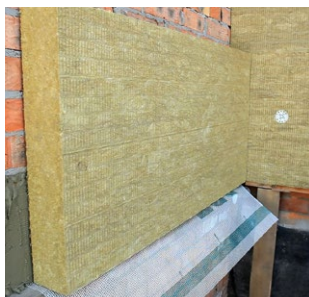
Рис. 7.26.б. Установка опорного профиля для первого ряда теплоизоляции с применением деревянного бруса
