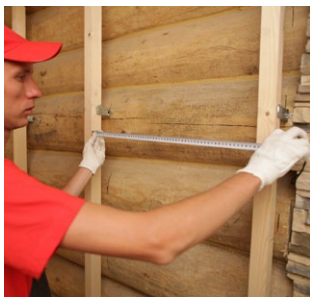
Рис. 6.13. Установка каркаса под теплоизоляцию
