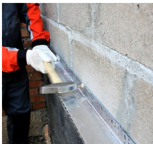
Рис. 7.26.а. Установка опорного профиля для первого ряда теплоизоляции с применением алюминиевого стартового профиля
