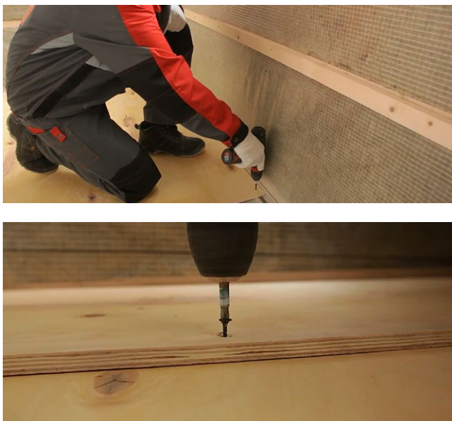
Рис. 7.54. Установка покрытия пола
