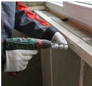
Рис. 7.44. Установка горизонтального каркаса под теплоизоляцию
