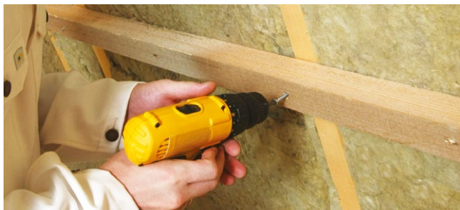
Рис. 4.4.а. Укладка второго слоя теплоизоляции
