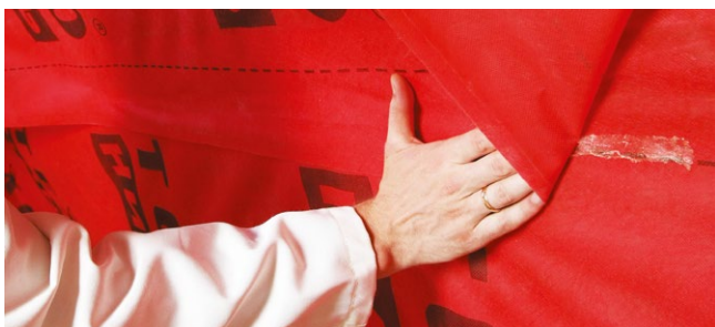
Рис. 4.6. Проклейка стыков пароизоляционной пленки
