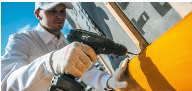
Рис. 7.23.а. Монтаж облицовочного материала
