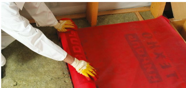
Рис. 4.12. Монтаж ветро-, влагозащитной мембраны
