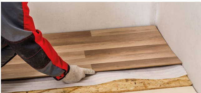
Рис. 5.5. Монтаж чистового покрытия
