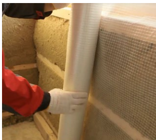
Рис. 7.46. Монтаж пароизоляции
