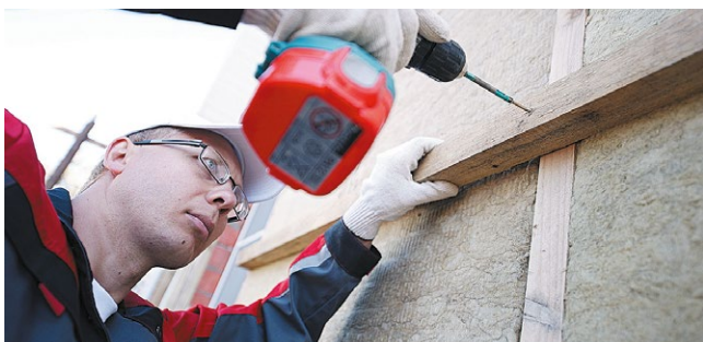
Рис. 7.3. Установка горизонтального каркаса
