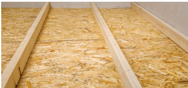
Рис. 5.1. Подшивка лаг снизу
