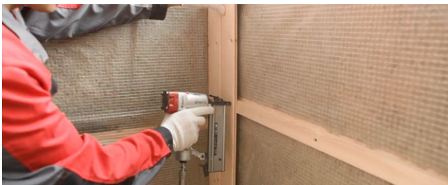
Рис. 7.48. Устройство внутренней обшивки
