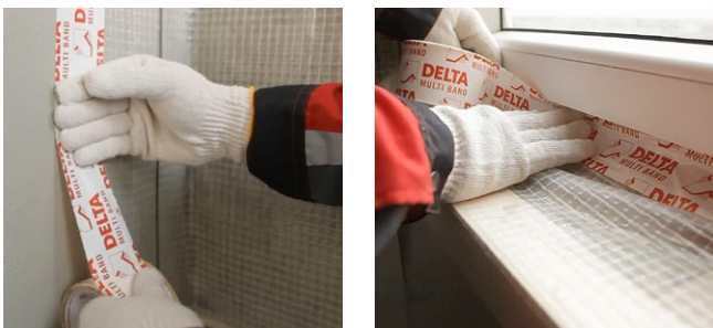
Рис. 7.53. Проклейка примыканий пароизоляции к стенам и окну
