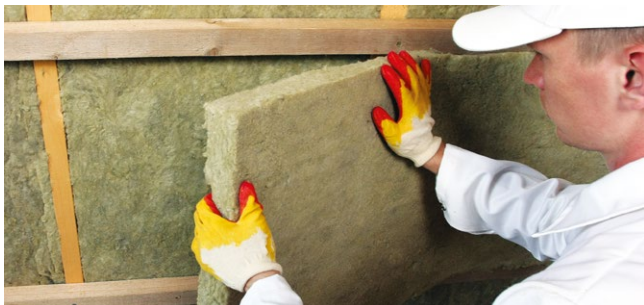
Рис. 4.4.б. Укладка второго слоя теплоизоляции
