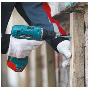
Рис. 7.1. Крепление вертикальных стоек деревянного каркаса
