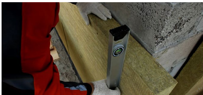
Рис. 7.31. Приклейка плиты тепло-, звукоизоляции к стене
