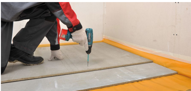
Рис. 5.11. Устройство сборной стяжки
