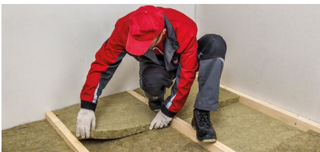
Рис. 5.2. Монтаж теплоизоляции враспор между лагами
