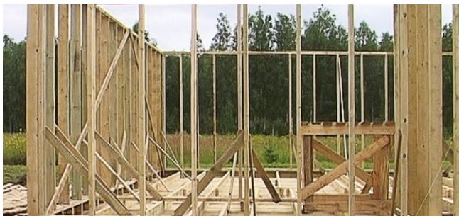
Рис. 7.19. Установка деревянного каркаса
