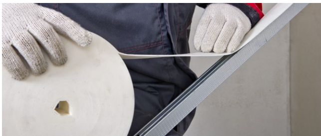
Рис. 6.9. Приклейка уплотнительной ленты к профилям
