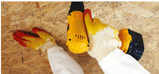
Рис. 4.10. Подшивка потолка листами ОСП
